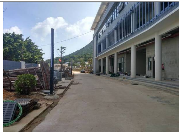
照片 1 2#北侧场地现状
