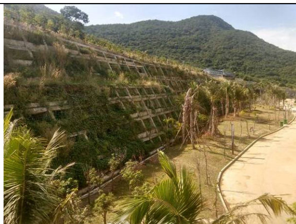
照片 28 边坡防护工程
