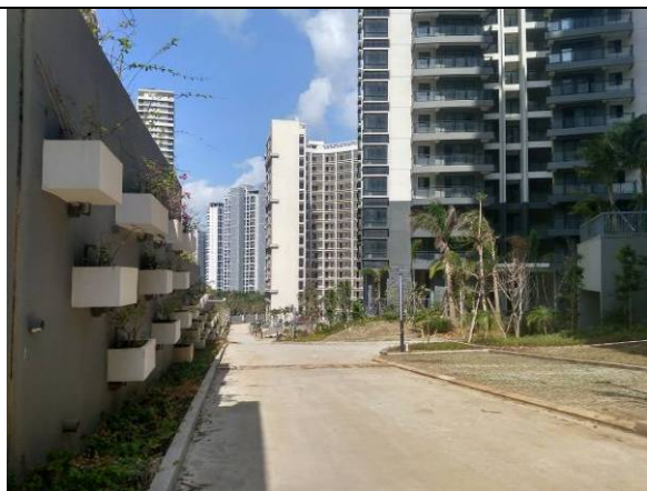
照片 7 项目西侧场地现状
