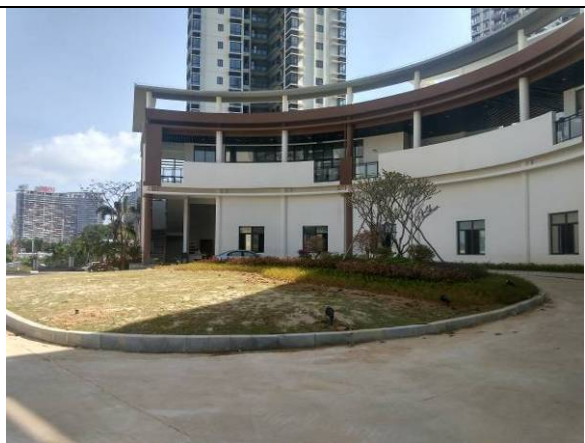
照片 18 会所北侧场地现状
