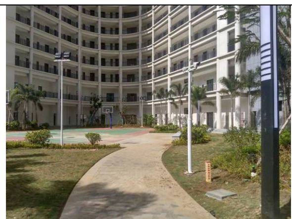
照片 6 研究生宿舍南侧场地现状
